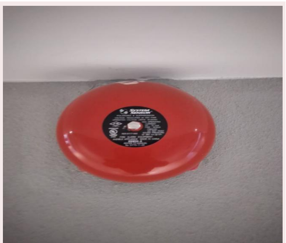
รูปที่ 2.4.6.1-6 กริ่งสัญญาณเตือนภัย
